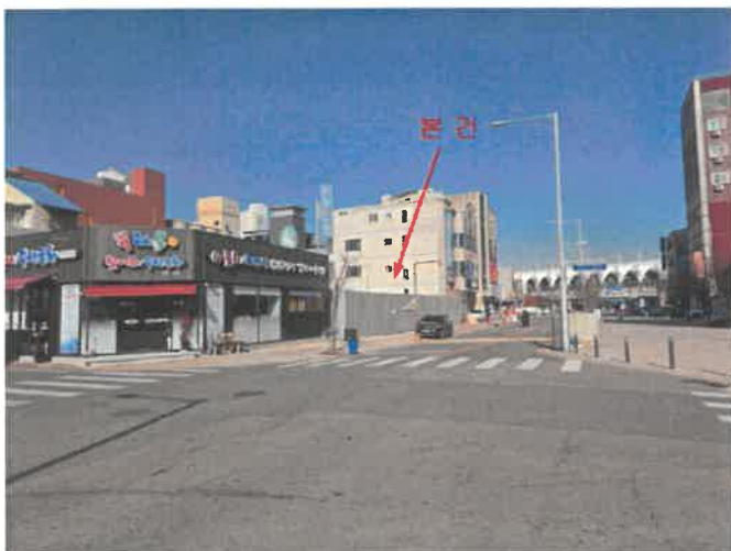
본건 및 주변 전경
